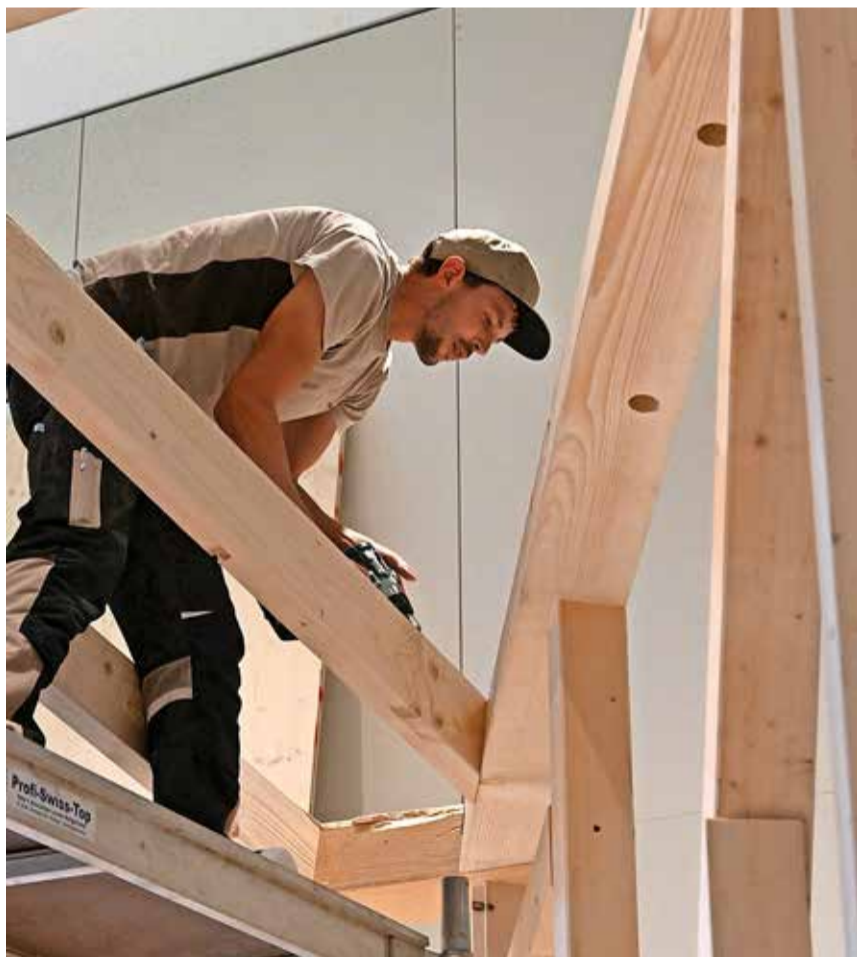
Adrian Roth beim Befestigen eines Balkens.
